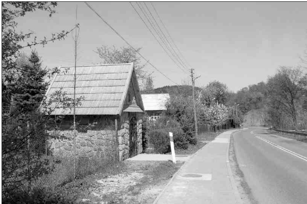
Kapliczka po przebudowie
