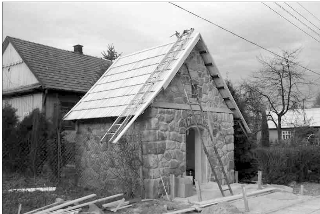
Kapliczka w trakcie przebudowy
