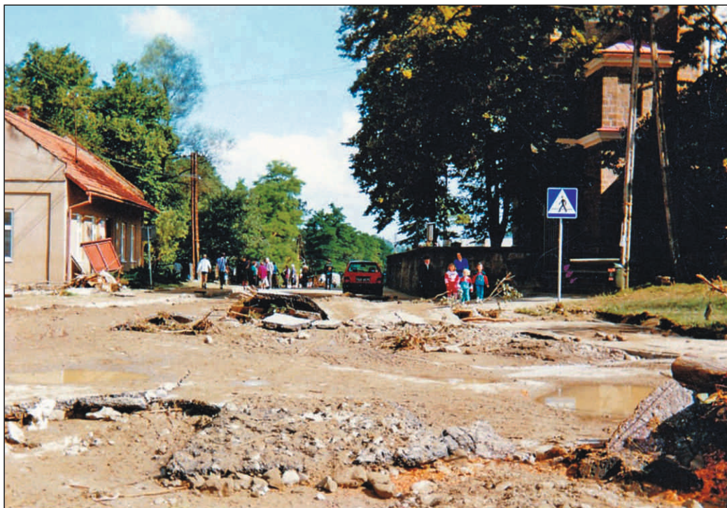
Zniszczona droga w centrum powyżej kościoła
