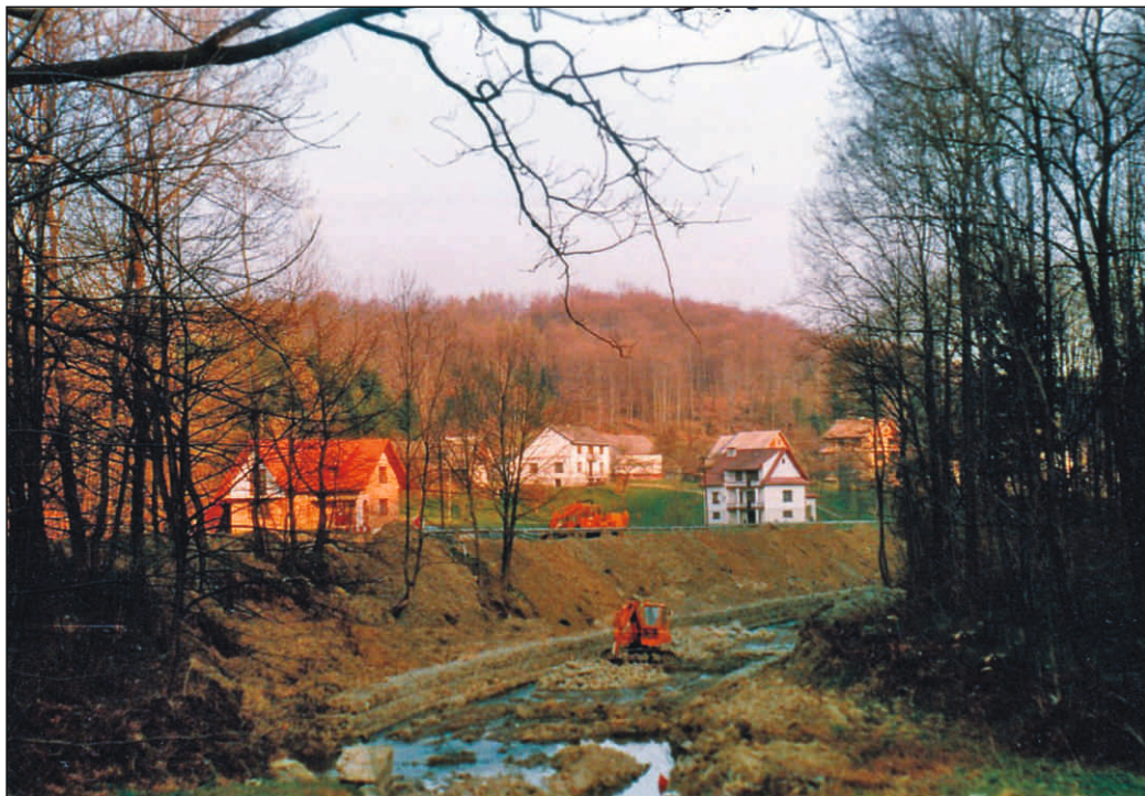
Odbudowa koryta i umacnianie brzegów potoku
