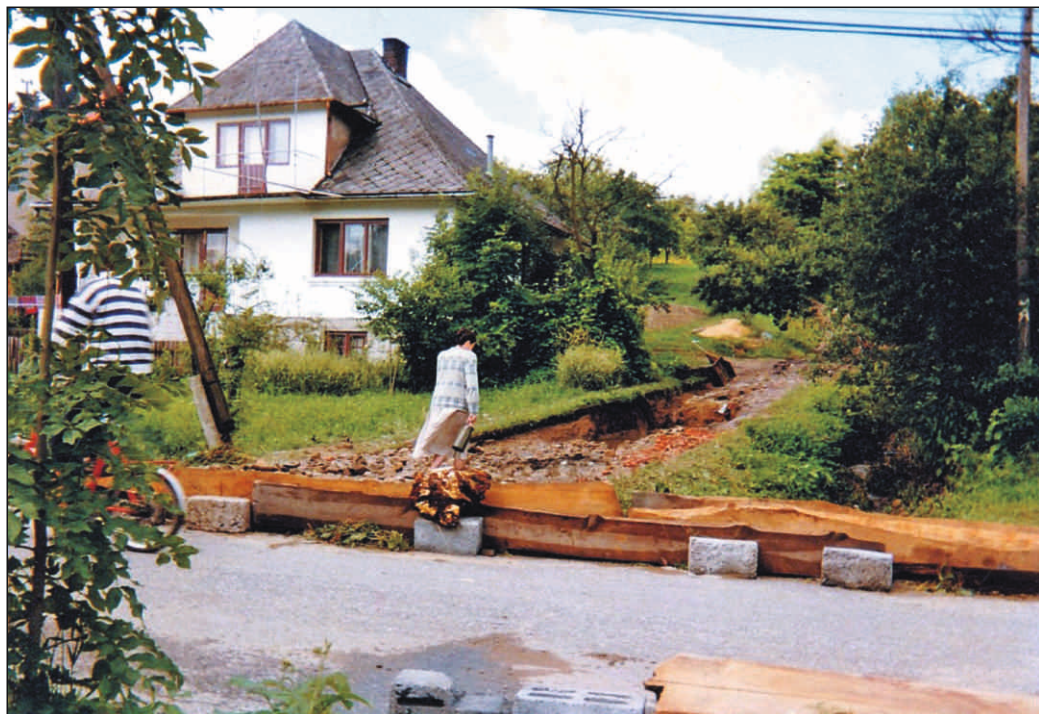
Zniszczona droga osiedlowa
