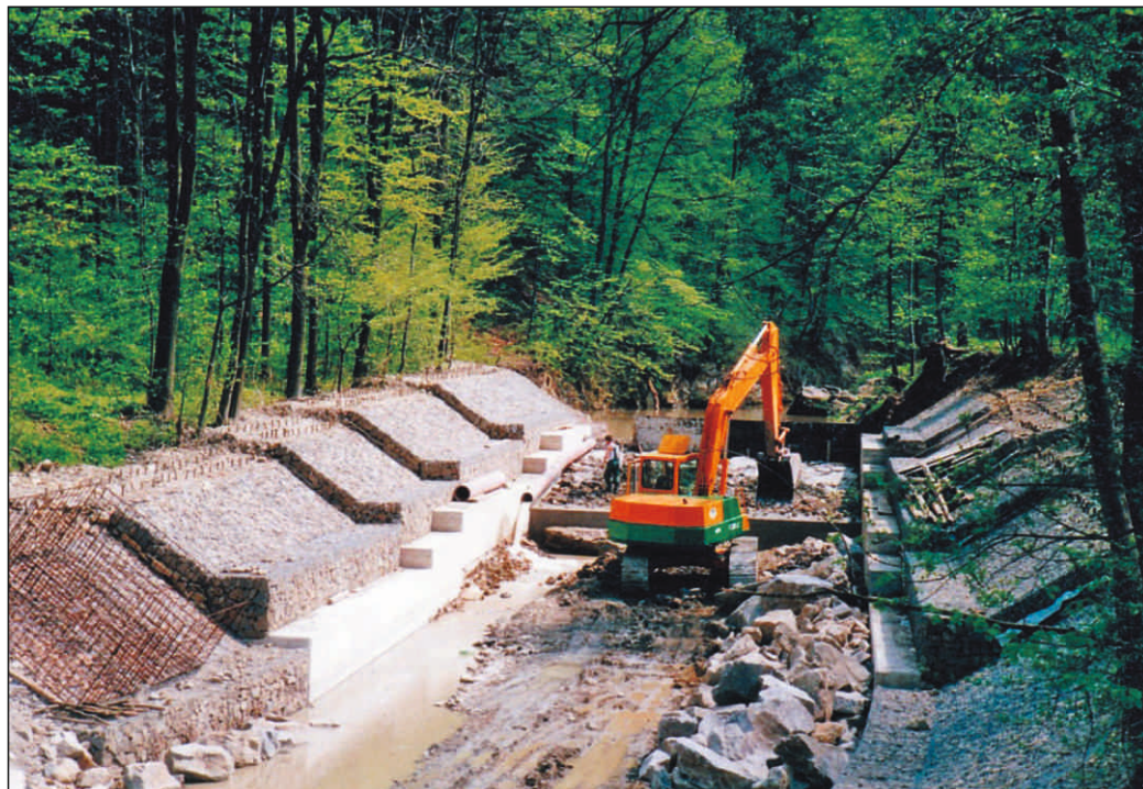
Budowa umocnień brzegów i dna potoku
