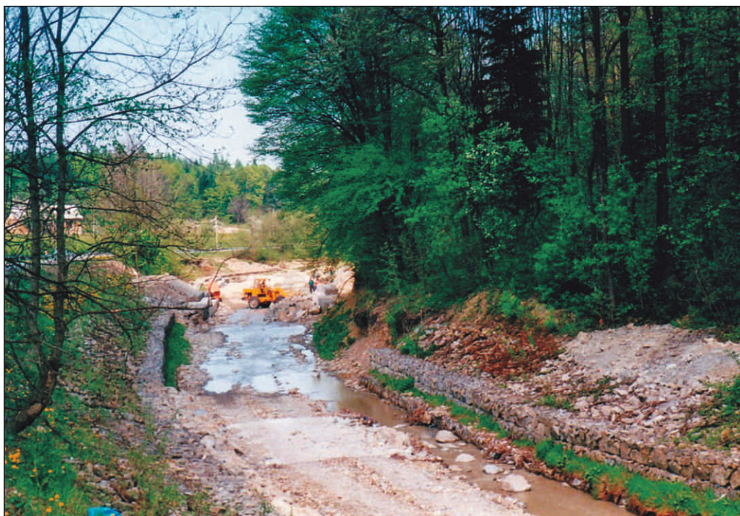
Odbudowa koryta i umacnianie brzegów potoku
