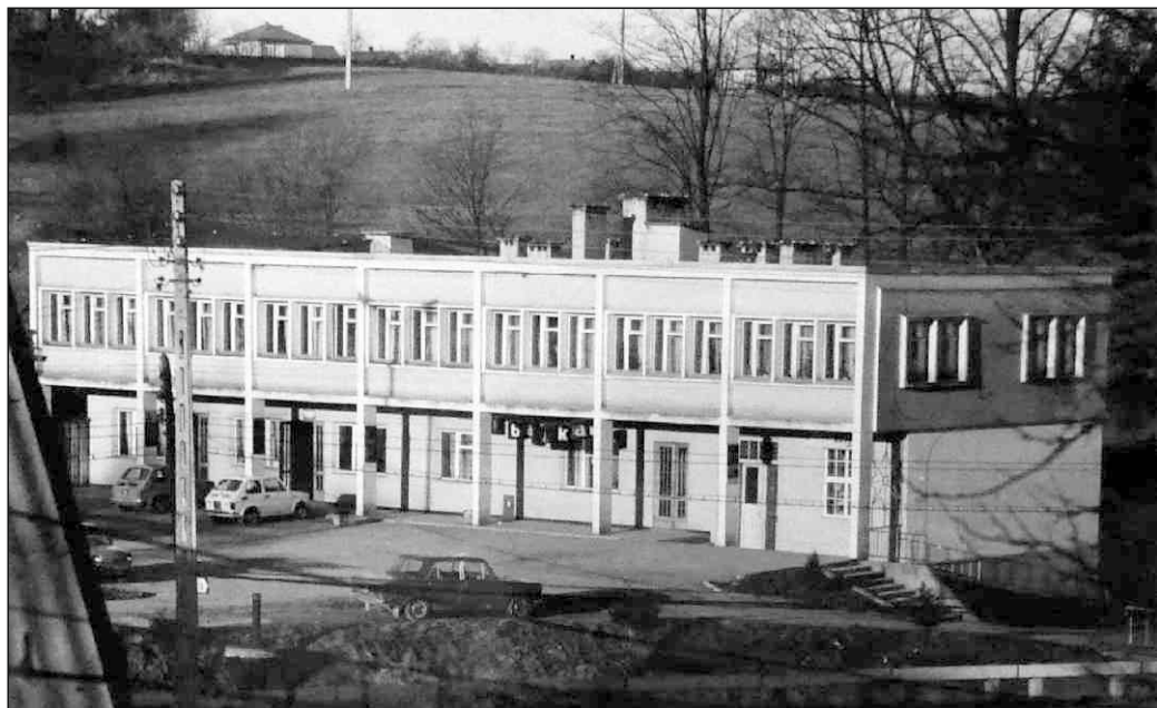
Budynek administracyjny – biurowy Gminnej Spółdzielni w Żegocinie.
