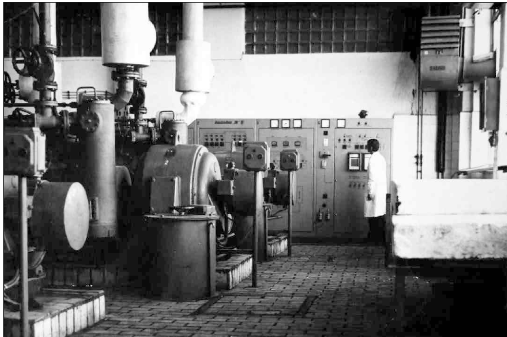
Serce zamrażalnictwa - maszynownia z automatycznym sterowaniem chłodzenia.
