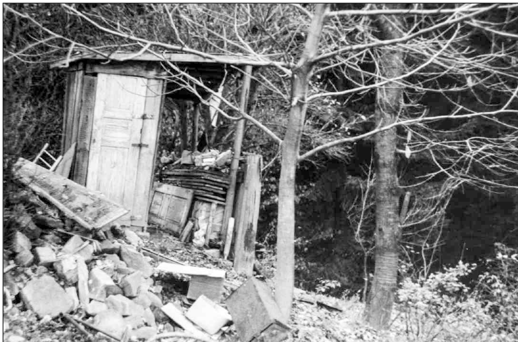
Obraz zniszczeń, fot. Jan Kępa.
