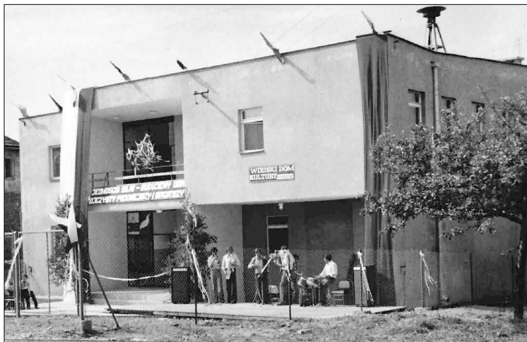
Nowy budynek Wiejskiego Domu Kultury w Leszczynie.
