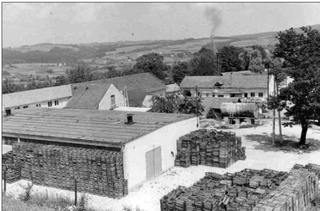
Obiekty Winiarni z Łątki Górnej (magazyn, biura, rozlewnia, fermentownia, produkcja oranżady).
