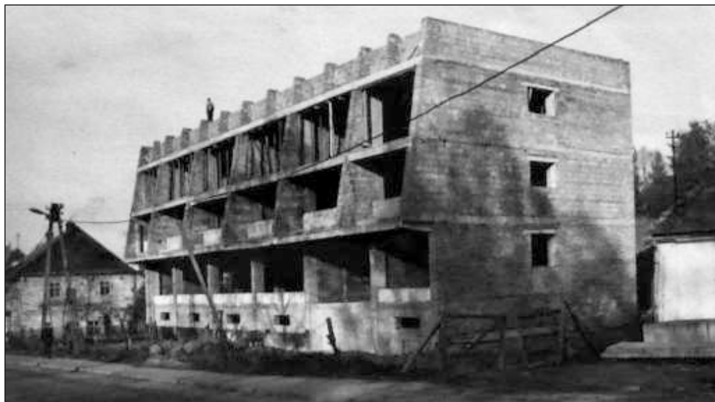
Etapy budowy Domu Administracyjnego.
