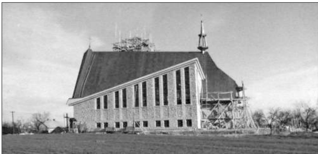
Kościół w Leszczynie w trakcie budowy.
