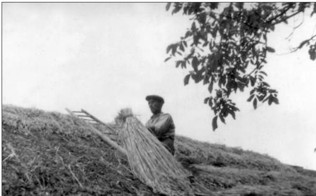
Naprawa słomianego dachu (strzechy).
